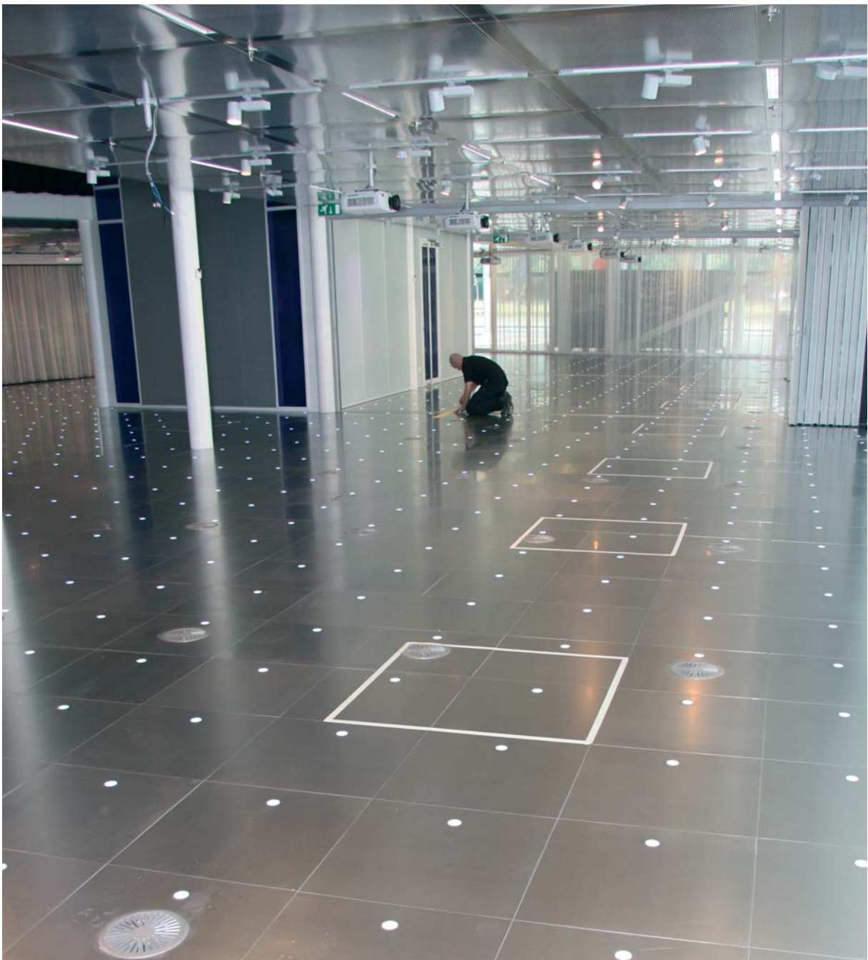
In het complex wordt veel led-verlichting toegepast. Alleen al in de vloer van de congressruimte zijn 1500 leds gemonteerd.
